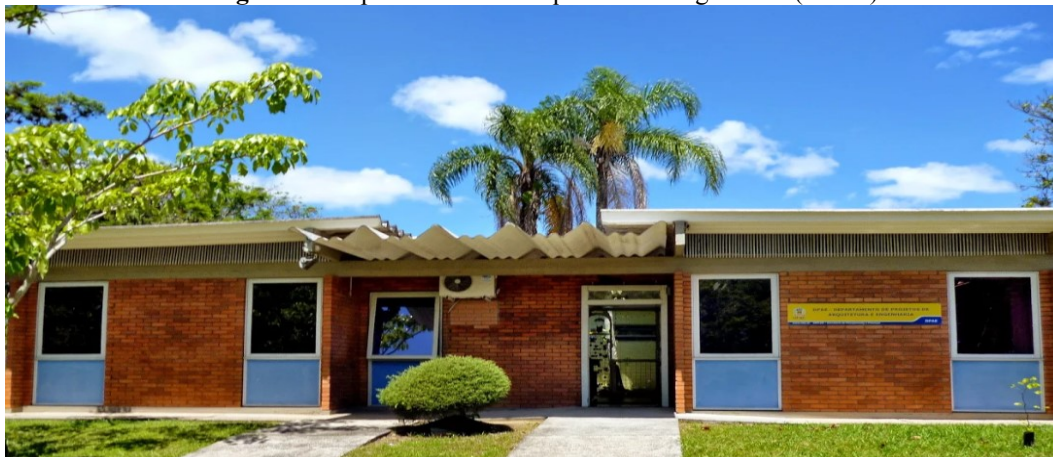
Imagem 1 – Departamento de Arquitetura e Engenharia (DPAE)
