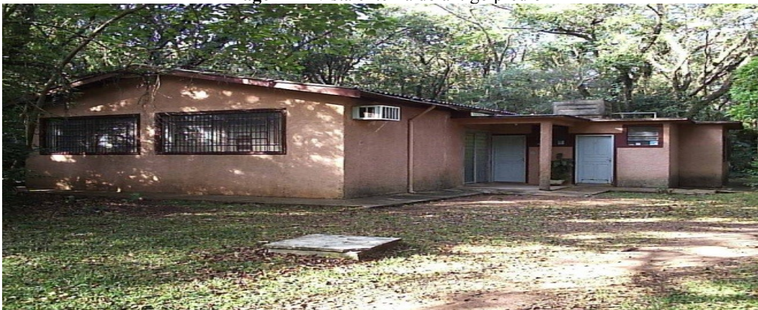
Imagem 2 - vista externa do antigo prédio
